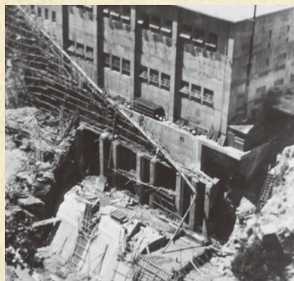
建設中の黒部川第三発電所。昭和15(1940)年発電開始(提供:関西電力)
